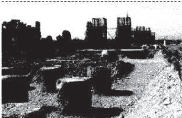
OSPITALETTO. In un'immagine del settembre scorso, ecco la base del rilevato ferroviario fra Travagliato e Ospitaletto: è solo un piccolo segmento dei 39 chilometri di «serpentone» da Treviglio a Roncadelle.
